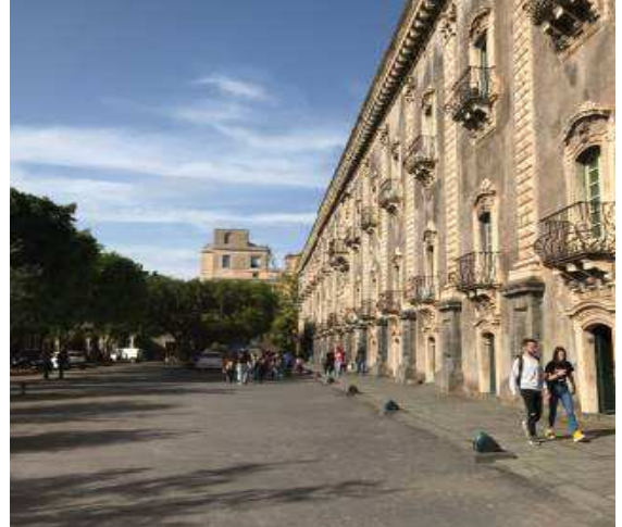
Cortile esterno PT
