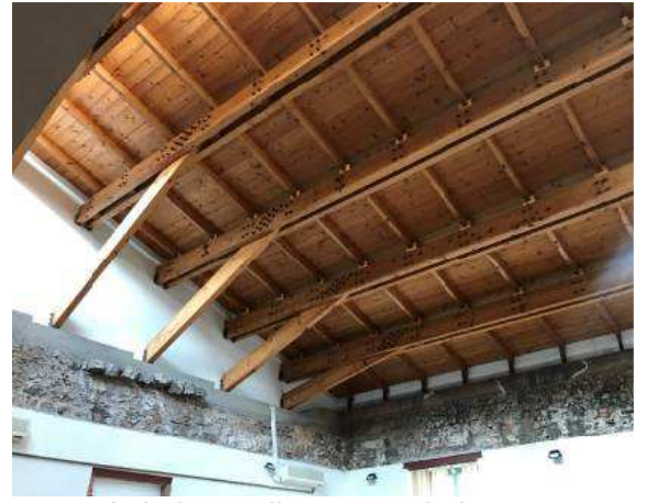
Aule laterali con tetto in legno
