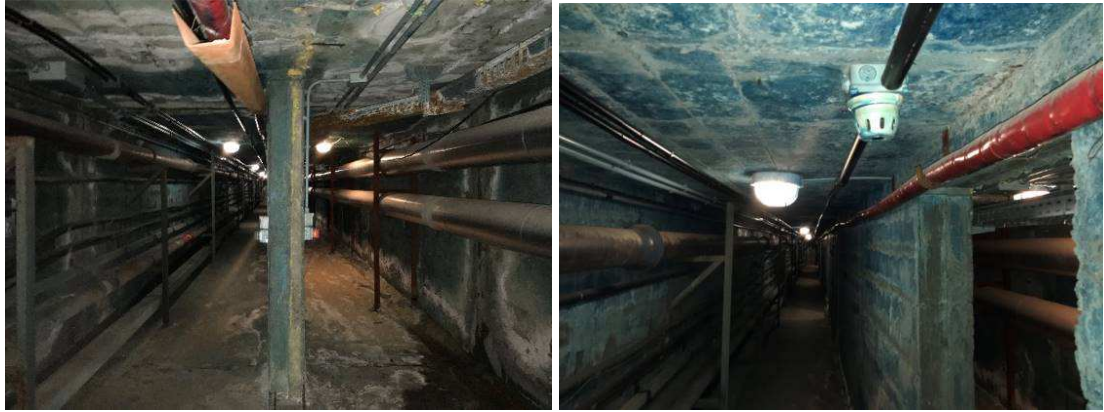
Tunnel tecnico - Cittadella Universitaria
