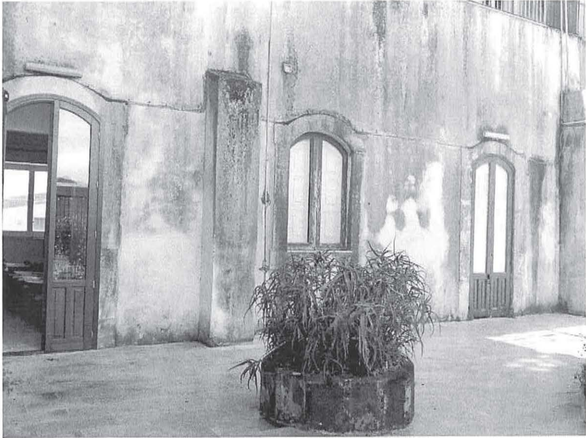
Foto 3 - Aula 7 (cortile lato Est)
