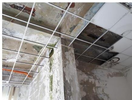
Nella sua totalità l'edificio è ricoperto da un consistente strato di deposito superficiale. Rilevante, sia per estensione che per consistenza, è anche la superficie intonacata soggetta a dilavamento. In corrispondenza delle terrazze, e più precisamente in corrispondenza dei relativi parapetti e cornicioni, a causa dell'inefficiente sistema di smaltimento delle acque piovane si ha una notevole presenza di coste nere e patina biologica.
