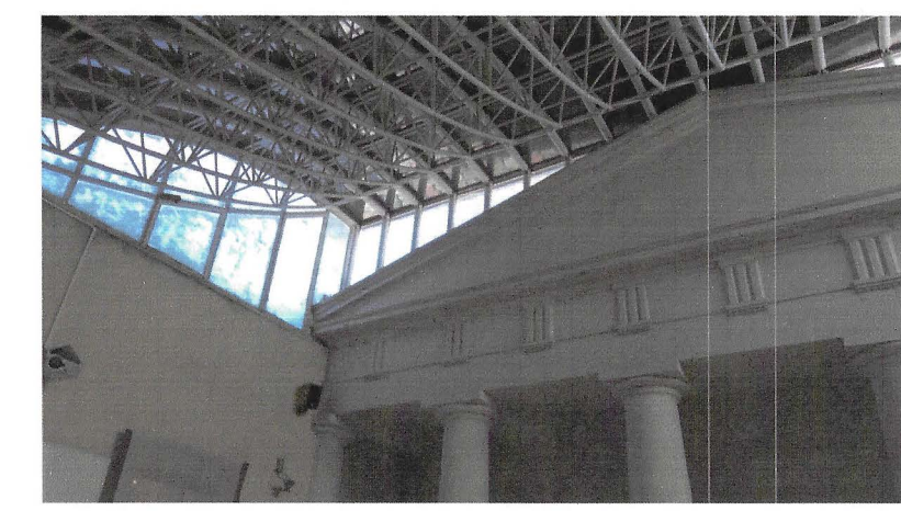
foto 8_ revisione copertura del colonnato (planimetria generale linea rossa tratteggiata), rifacimento di intonaco, sostituzione vetrate con applicazione di pellicole solari protettive (vedi voce: 21.05.18 - 21.01.10 - 09.01.09.01 - 08.04.03.01)
