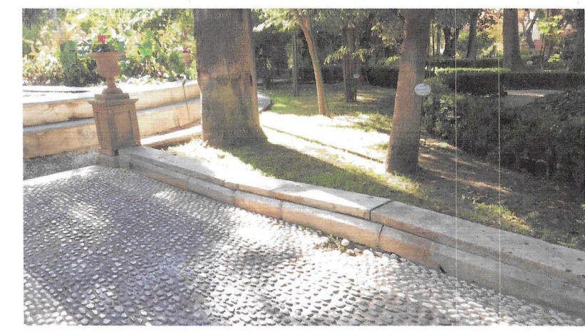
foto 3_ restauro e integrazione parti ammalorate dei cordoli in pietra arenaria (vedi voce: N.P.01)
