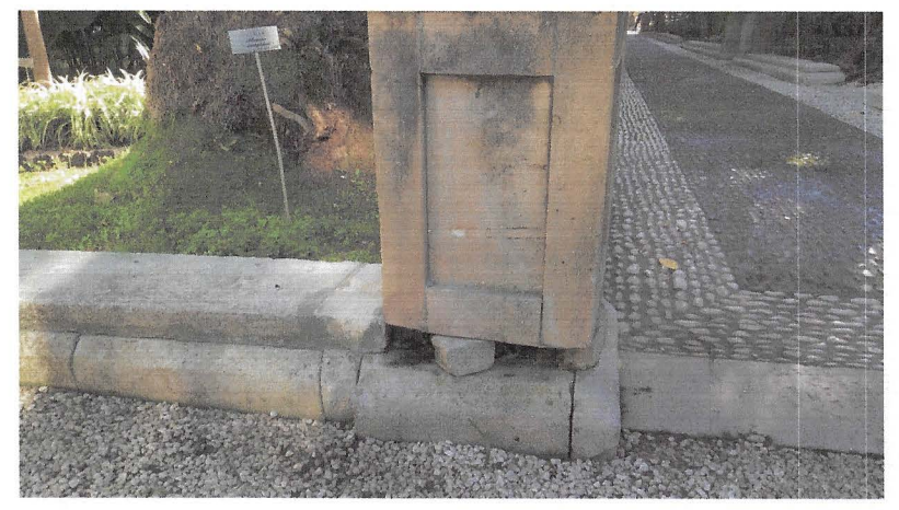
foto 1_ restauro e integrazione parti mancanti delle colonne in pietra arenaria (vedi voce: N.P.01)
