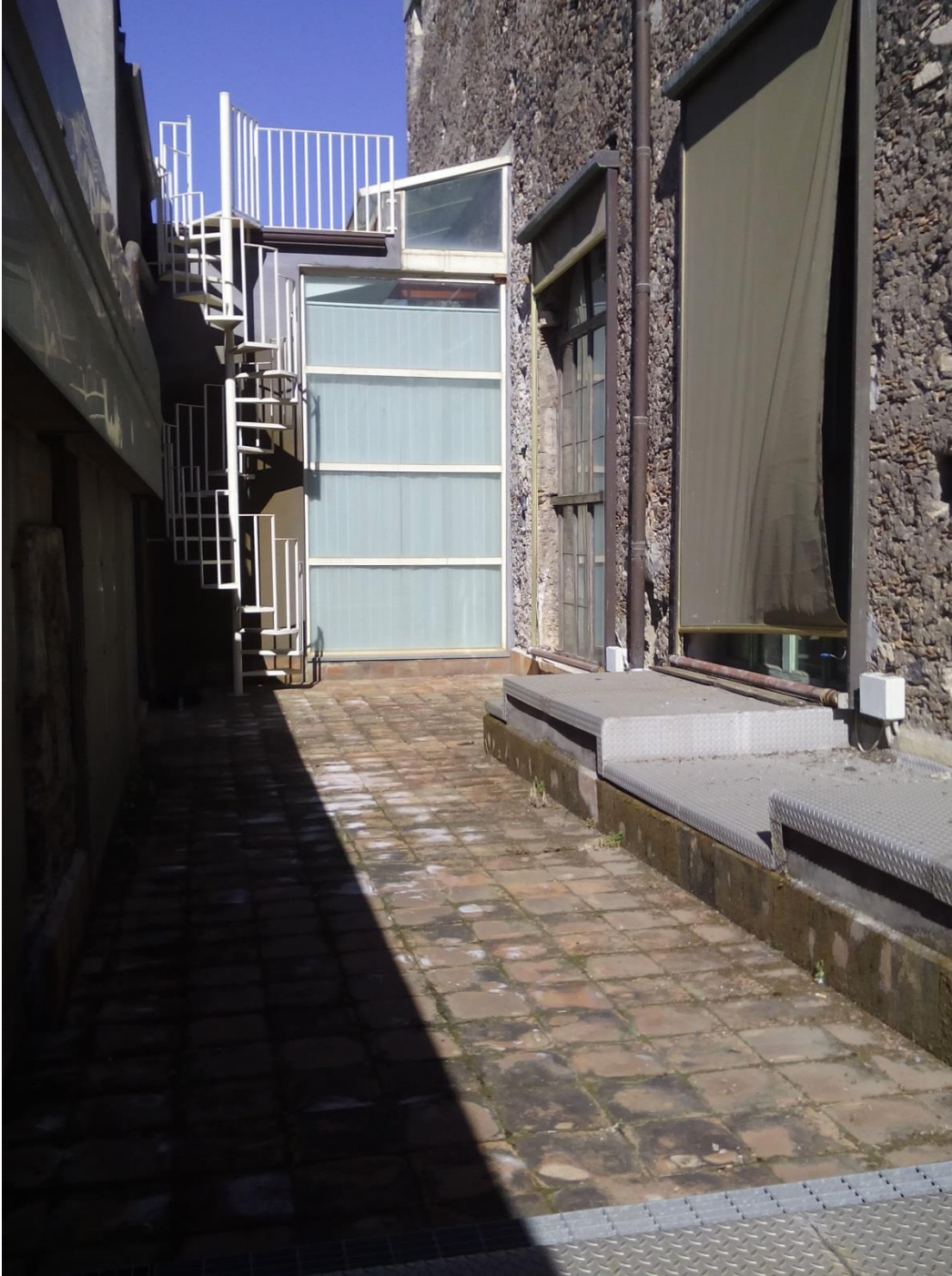
Figura 25 – Copertura piana corridoio Novizi
