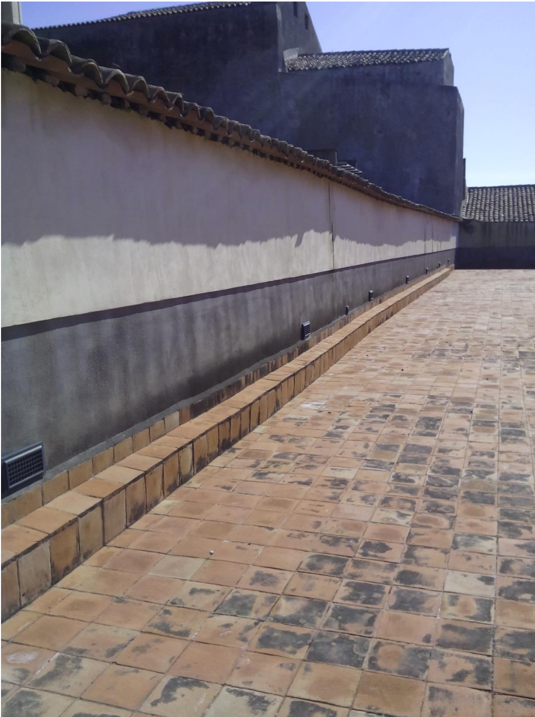
Figura 26 – Copertura piana corridoio Coro di Notte
