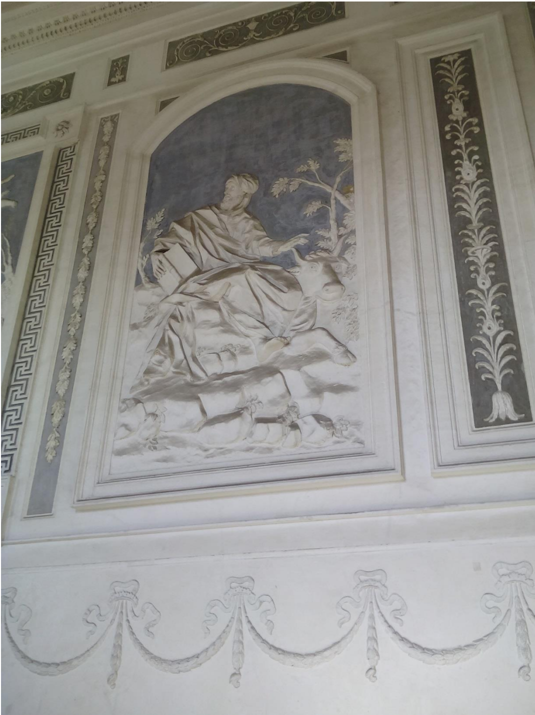
Figura 15 – pareti scalone monumentale
