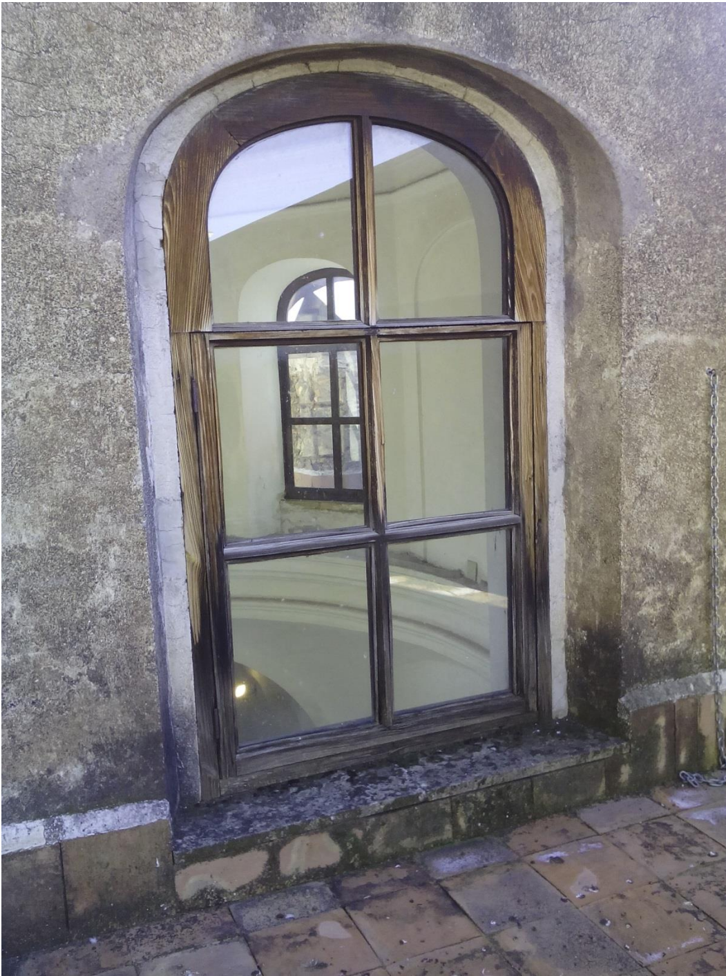
Figura 23 – Infissi esterni lucernaio corridoio Novizi
