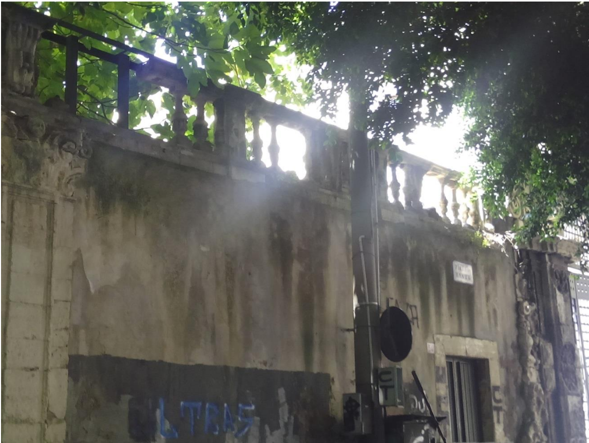
Figura 3 - balastra muro di recinzione su piazza Dante
