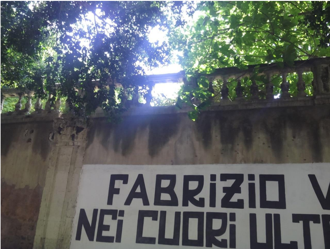
Figura 1 - balastra muro di recinzione su piazza Dante
