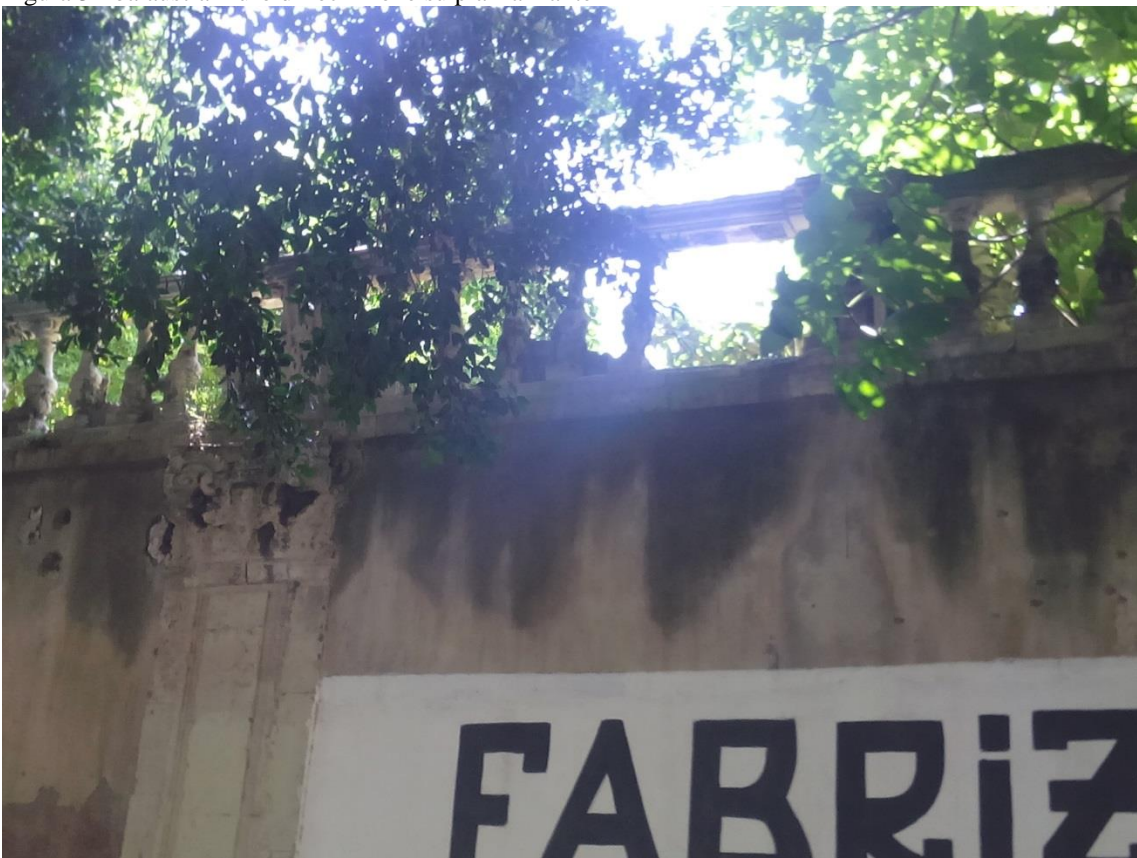
Figura 4 - balastra muro di recinzione su piazza Dante
