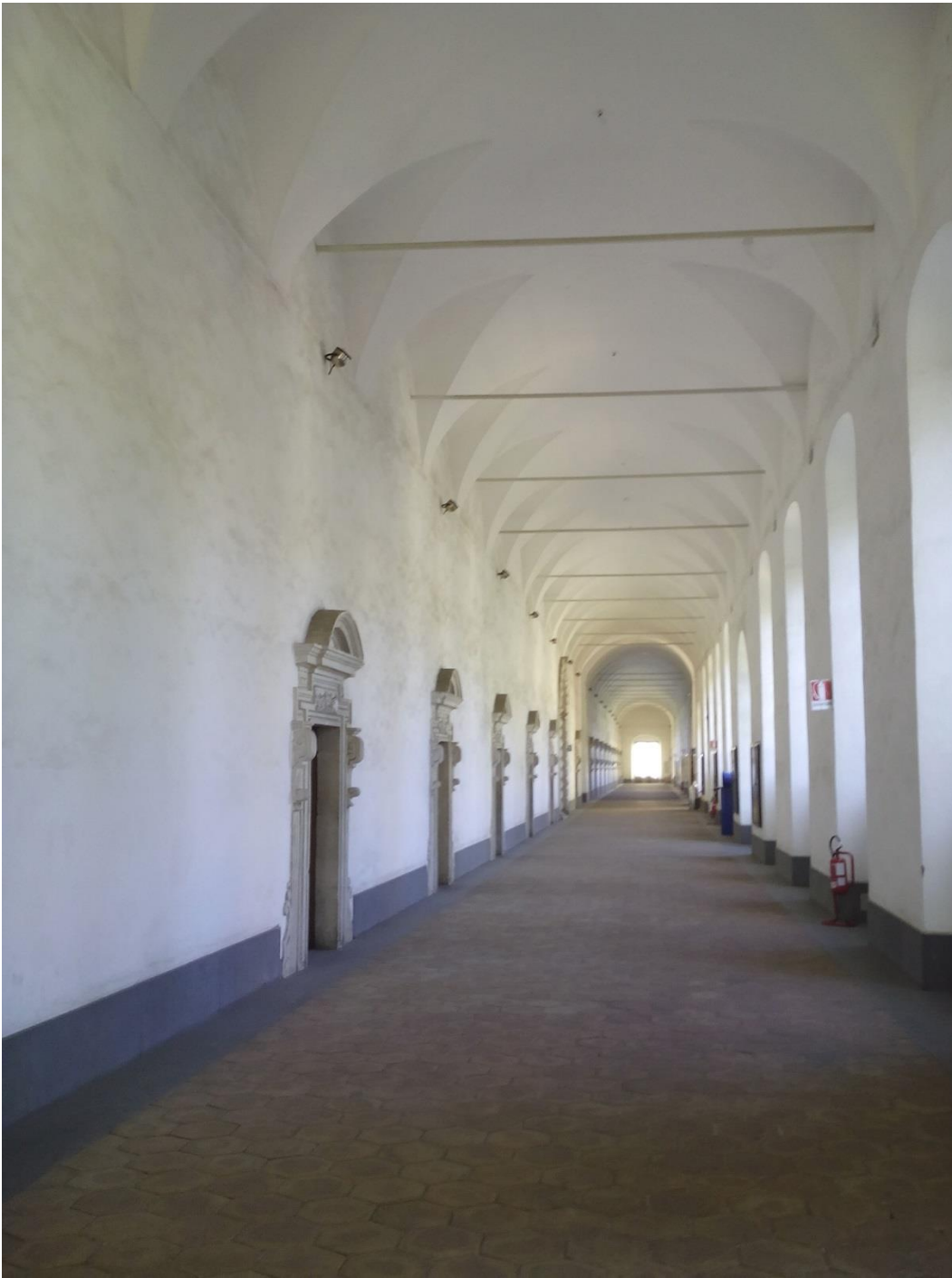
Figura 9 – pareti e soffitti corridoi interni
