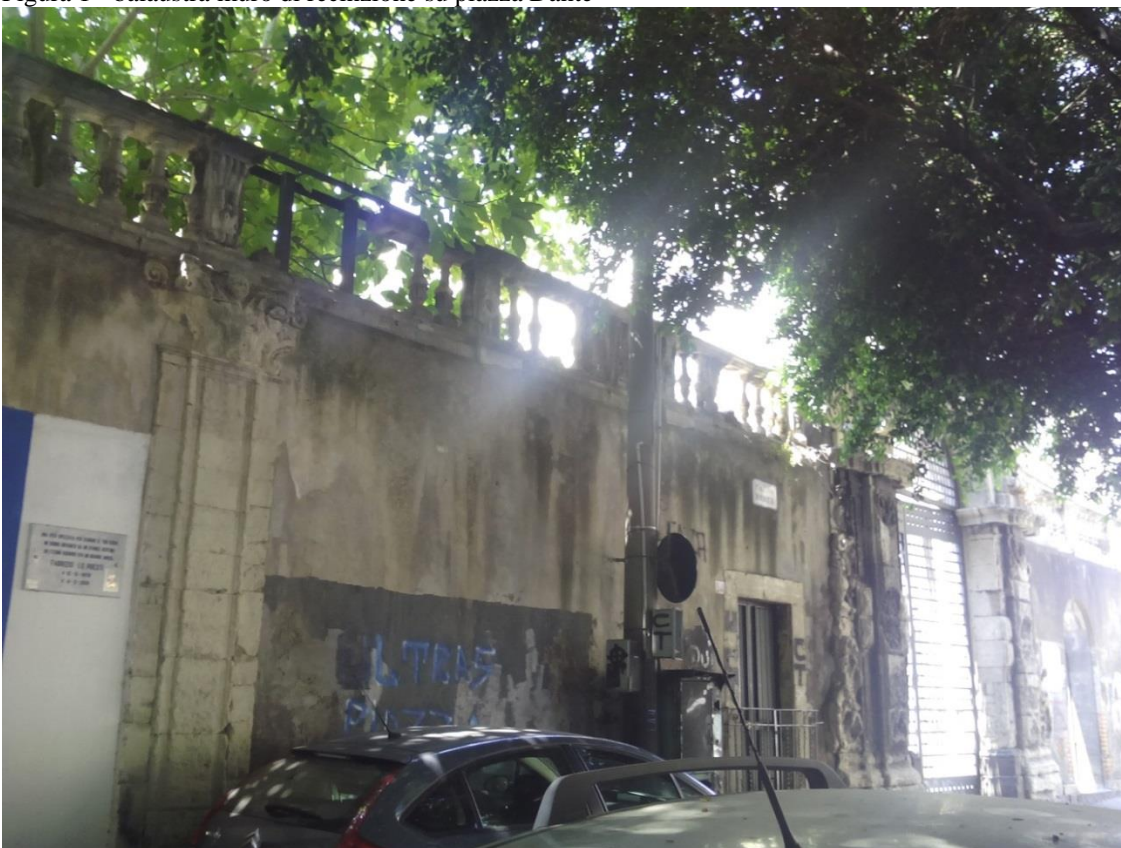
Figura 2 - balastra muro di recinzione su piazza Dante
