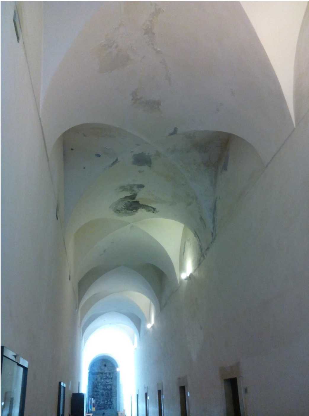
Figura 10 – pareti e soffitti corridoi interni
