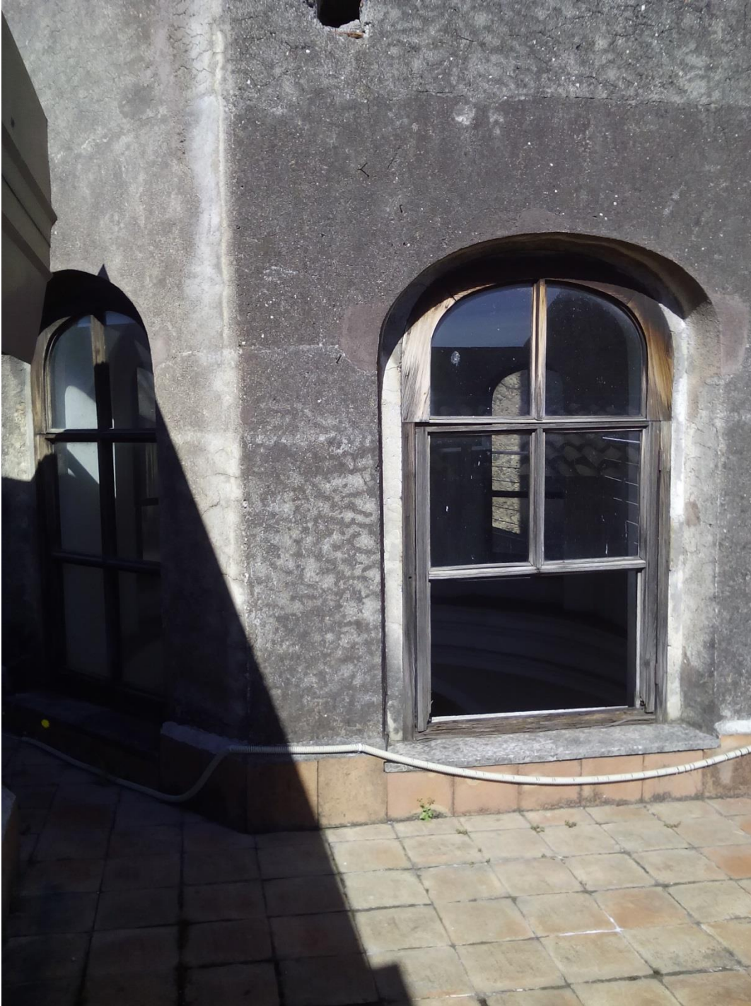
Figura 24 – Infissi esterni lucernaio corridoio Novizi
