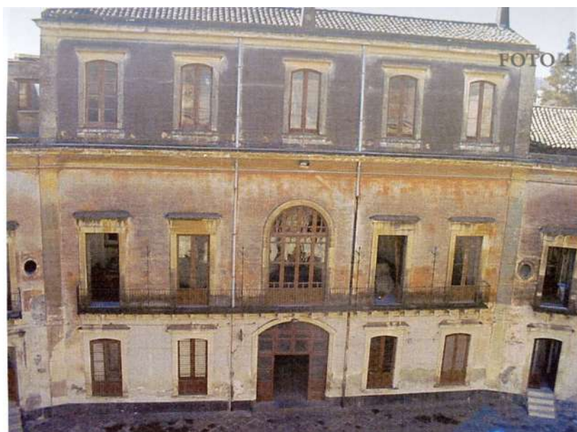
Figura 9. Immagine del 2004 che raffigura parte della corte interna: si nota l'originale trattamento delle superfici con scialbatura giallo oca.
