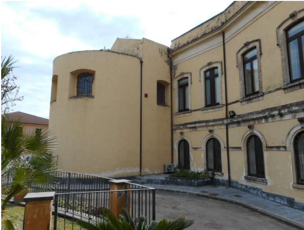
Figura 3.3. Prospetto Nord – Est - cono ottico 3
