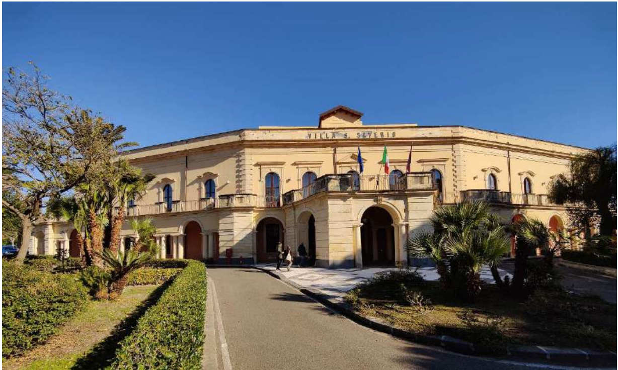
Figura 3.1. Prospetto Sud in prossimità dell'ingresso principale – cono ottico 1
