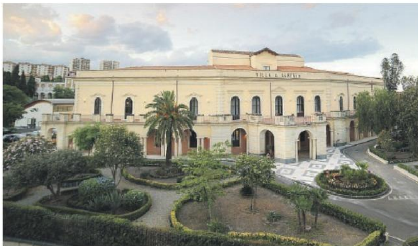
Villa San Saverio, sede della Scuola Superiore
